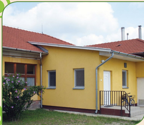
Bacsó Béla úti iskolaépület
